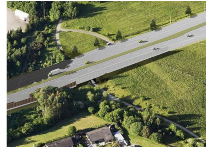
Underføring af stitunnel ved Frederikssunds østlige bygrænse
