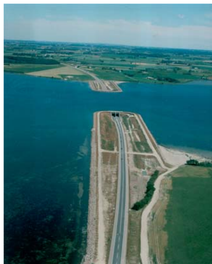
Guldborgsundtunnelen – en "kort tunnel"
