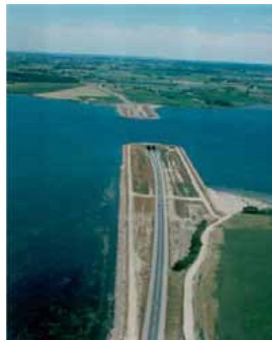
Guldborgsundtunnelen – en "kort tunnel"
